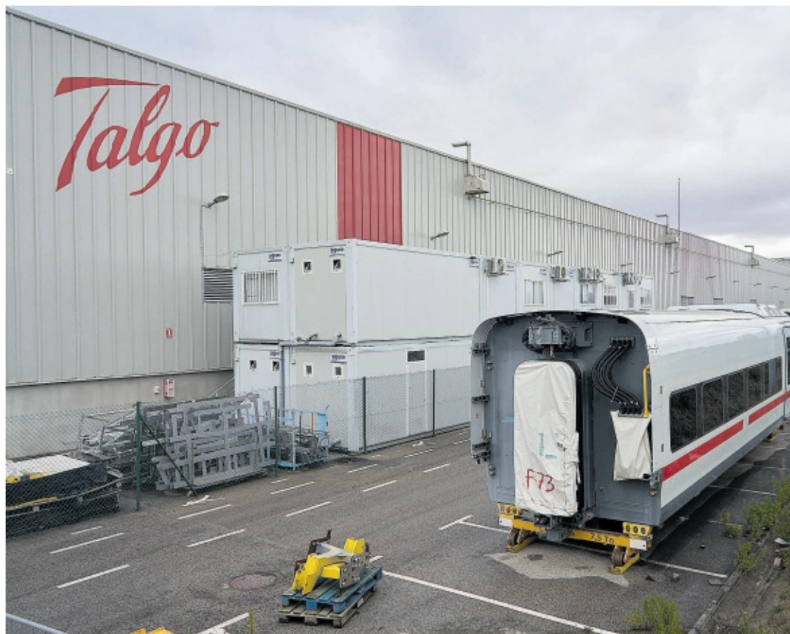
Vista de la planta de Talgo en Álava. EFE
