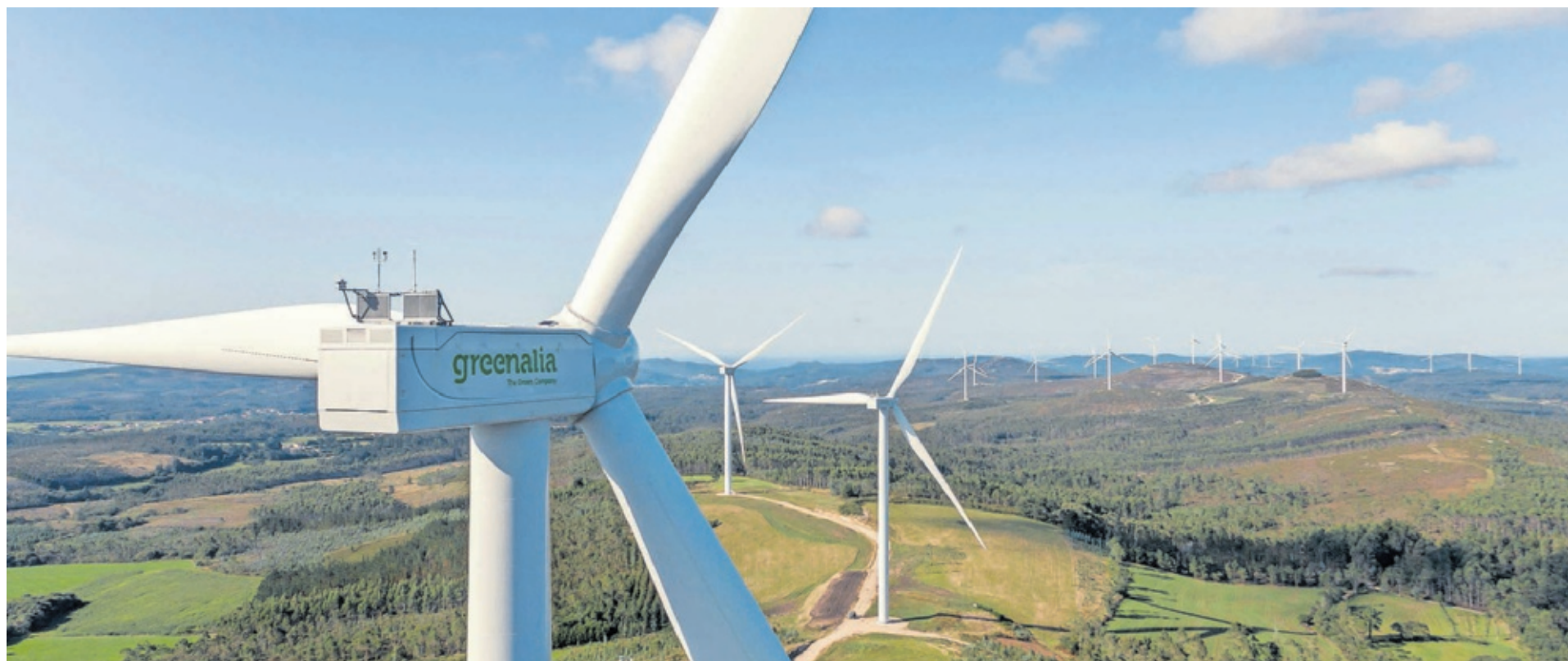
Vista del parque eólico Monte Tourado de Greenalia en Vimianzo (A Coruña). CEDIDA POR LA EMPRESA
