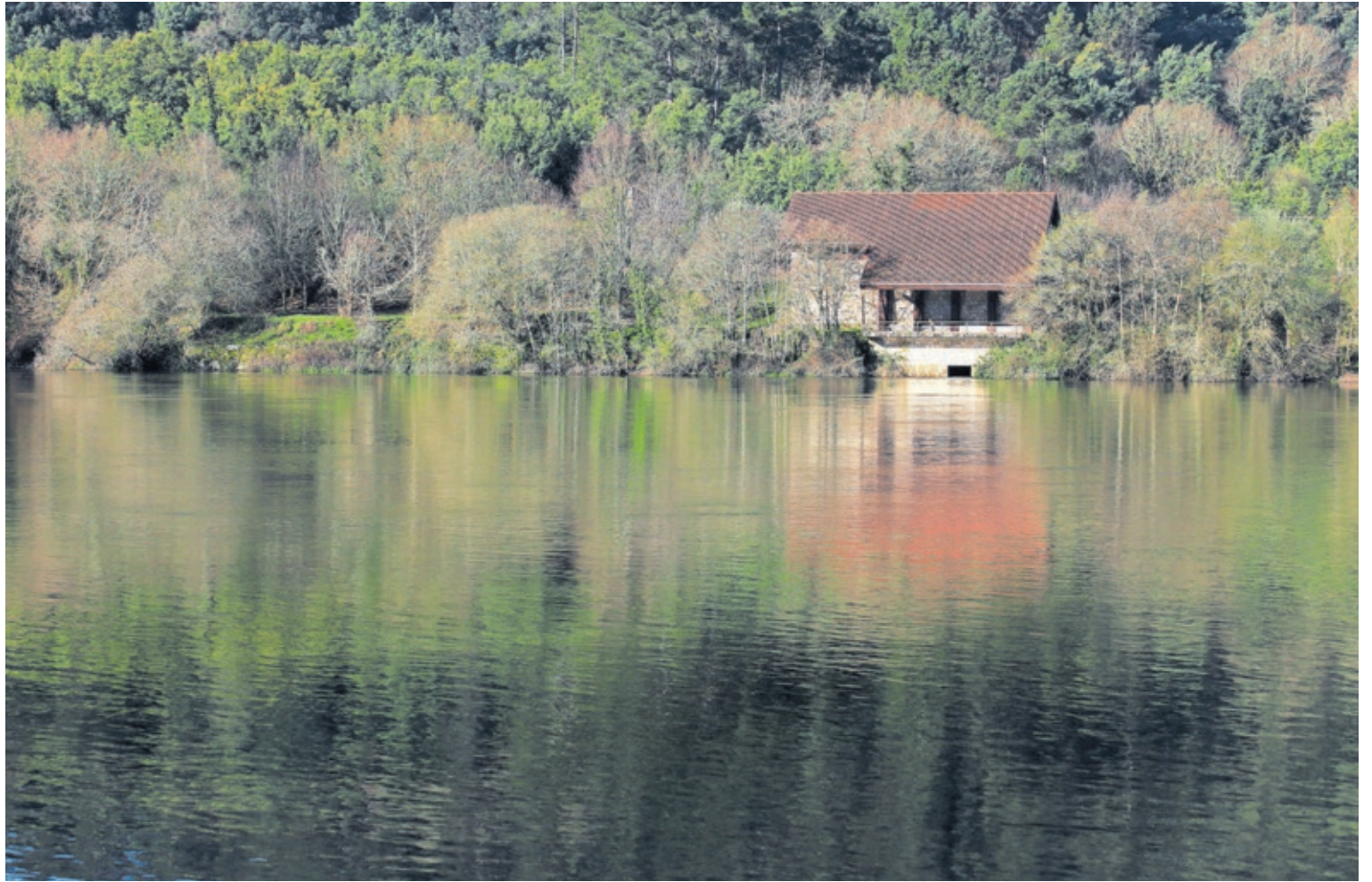
CENTRAL HIDROELÉCTRICA DE CIERVES DE ECOENER, SITUADA ENTRE LOS MUNICIPIOS DE RIBADAVIA Y MELÓN (OURENSE, GALICIA).
