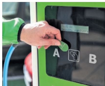
Fenie Energía permite solicitar una tarjeta de acceso al punto de recarga.
