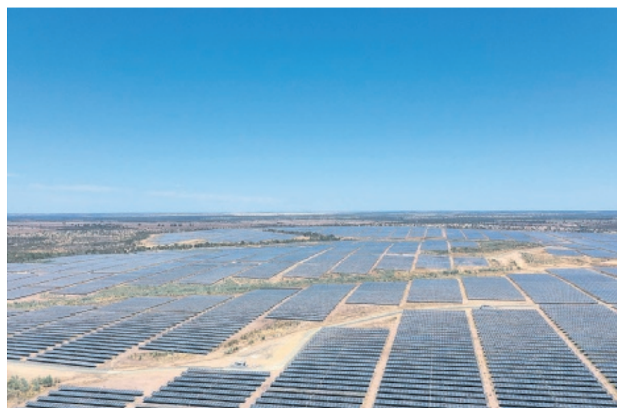
Planta fotovoltaica de Gransolar 120 MW en Australia
