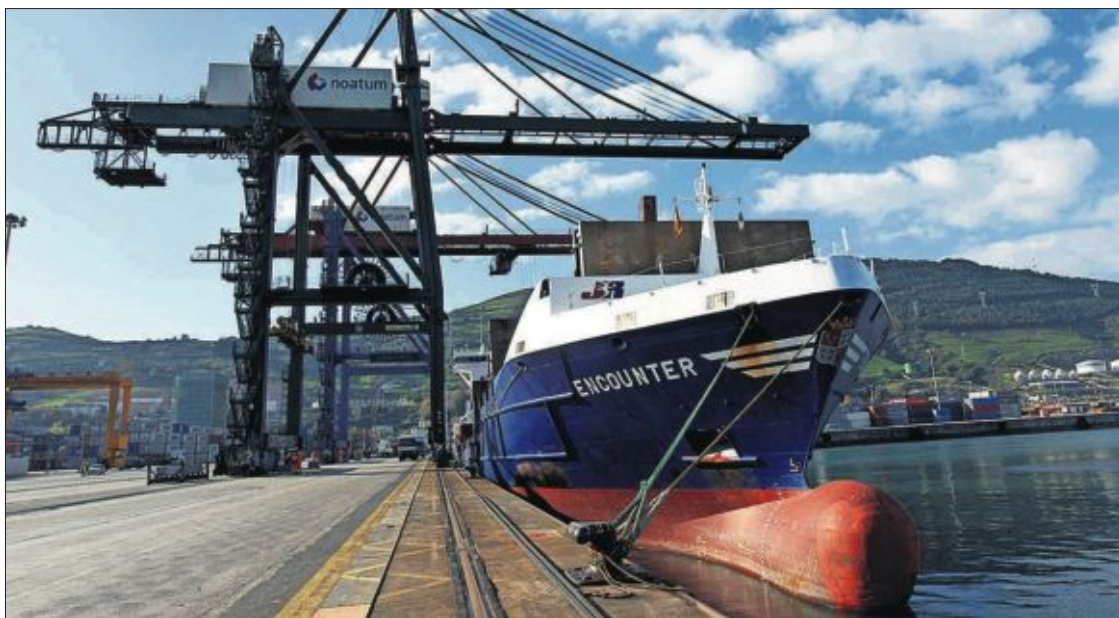
En el futuro los buques atracarán de manera automática en los muelles. / FERNANDO DOMINGO-ALDAMA
