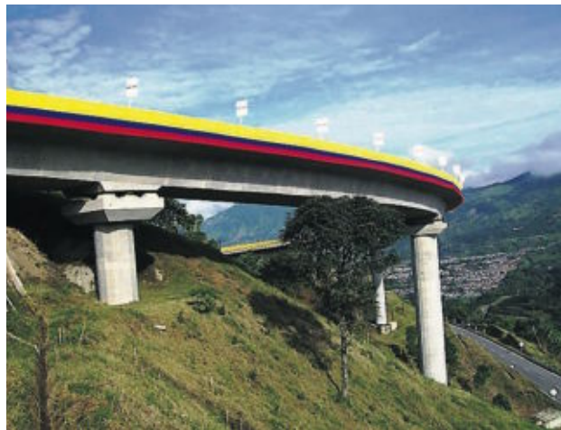
Arriba, variante Espinal-Guamo el día de su inauguración, en noviembre de 2014. Sobre estas líneas, vista del puente helicoidal de la autopista del Café.
