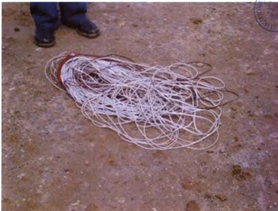
VISTA DEL CONJUNTO DEL CABLEADO
